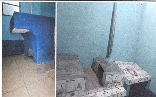
Foto1: Mejoramiento de cocina, pintura, balcón, puerta, instalación de poyeton, pila de cemento y cambio de balcones.
